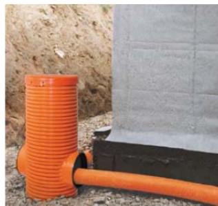
Figure 17 – Exemple d'installation du système Opti-drain
